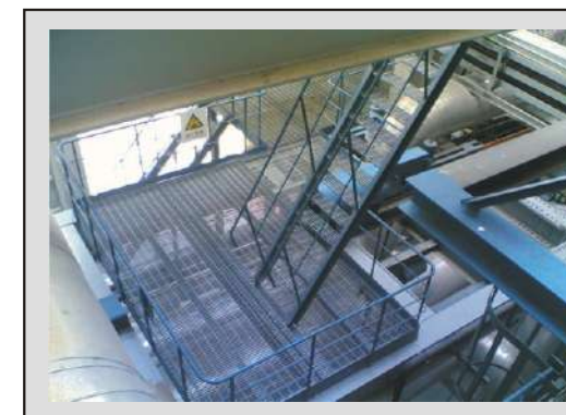
钢梯、扶手栏杆
